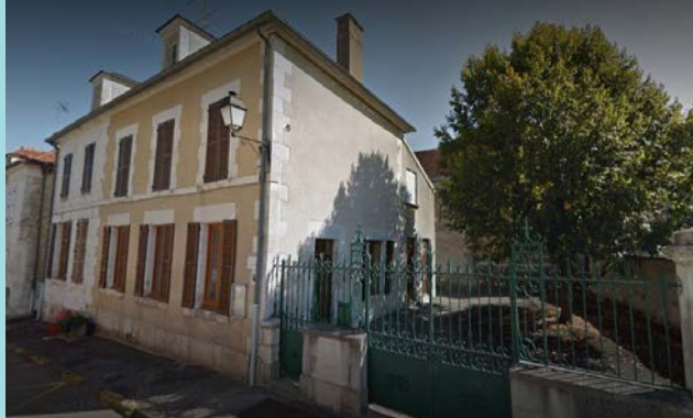
Réhabilitation d'un bâti à Jussy
